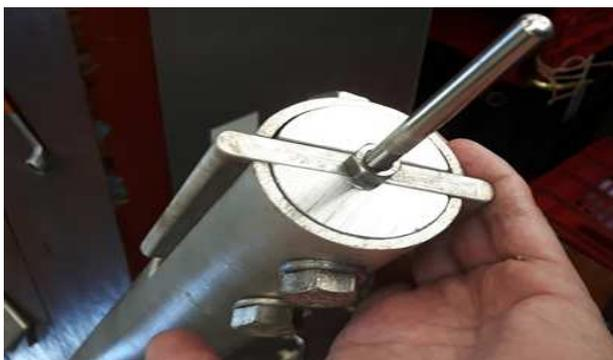
**Figura 4 – Arranjo confeccionado para aumentar a área de contato e evitar a corrosão galvânica.**
