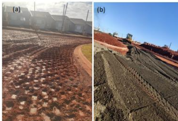
FIGURA 2. Regularização e compactação do subleito(a) e base estabilizada granulometricamente – BGS(b).
